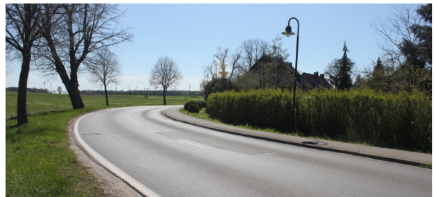
Abbildung 5 Blick Richtung Süden
